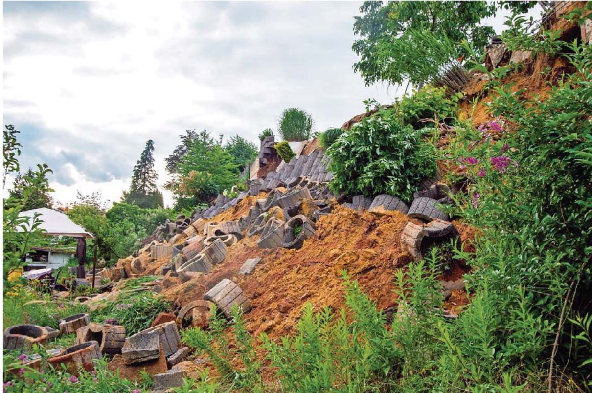
Der Hang zwischen Rothenbergstraße und Ginsterberg in Elm hat sich selbstständig gemacht.
