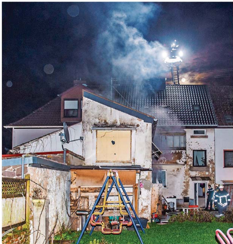
Im Hinterhaus dieses Anwesens in Roden brach das Feuer aus. Der Schaden belief sich auf 50 000 Euro.
