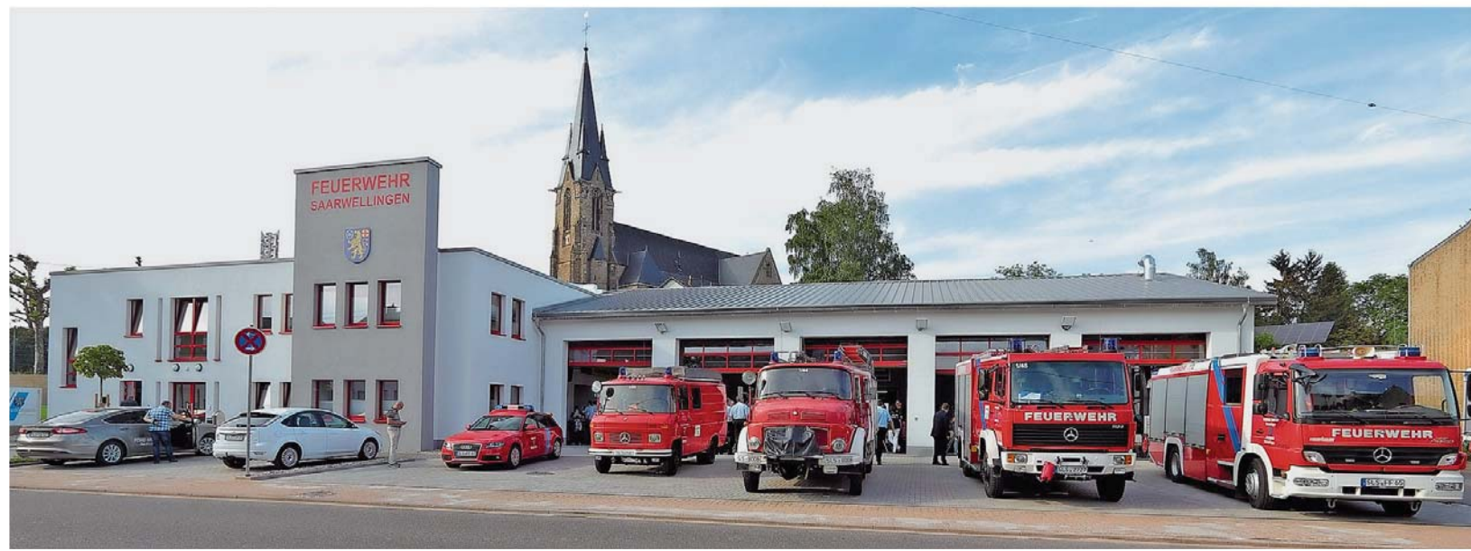
Einsatzbereit seit dem Wochenende: das neue Feuerwehrgerätehaus in der Saarwellingener Schlossstraße.
