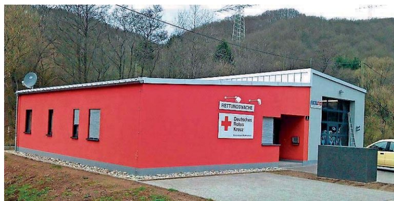
Die Rettungswache im Bohnental ist eine von sieben, die seit 2011 neu errichtet wurden; eine achte ist gerade im Bau. FOTO: ZRF
